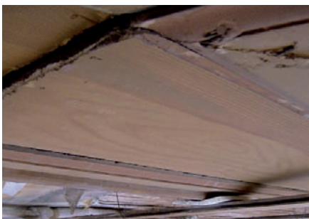
Orilla de panel desprendido.
