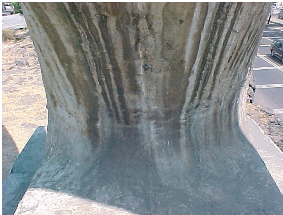
Presencia de productos de corrosión en la parte inferior.
