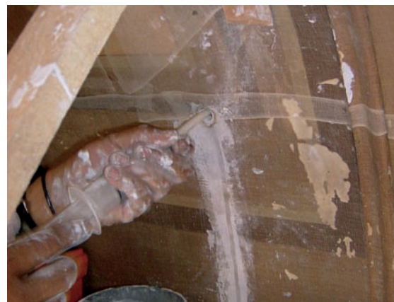
Consolidación de yeso a estructura de madera, fijación mayor.
