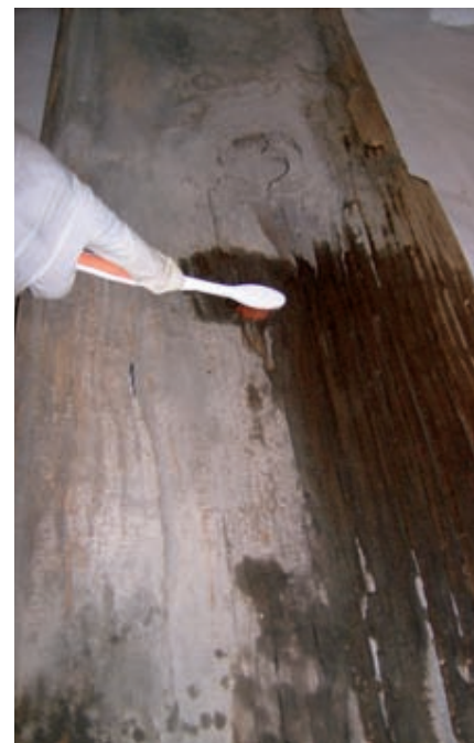
Limpieza de panel desmontado.
