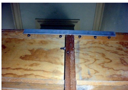
Ángulos de aluminio al finalizar los procesos de restauración.
