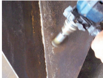
Remoción de corrosión con carda de latón.
