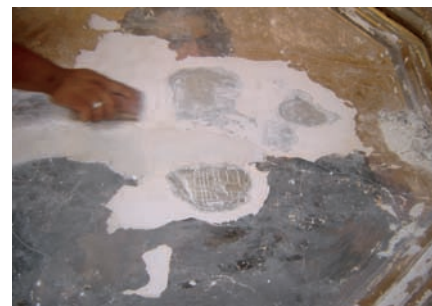
Desbaste de deformaciones.
