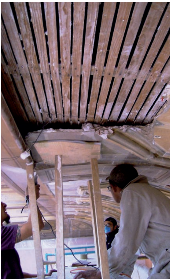
Apuntalamiento de áreas desprendidas.
