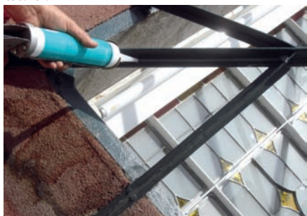
Colocación de policarbonato en domo y aplicación de silicona sellador, durante el proceso.
