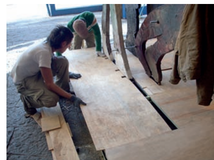
Sustitución de las láminas de triplay.
