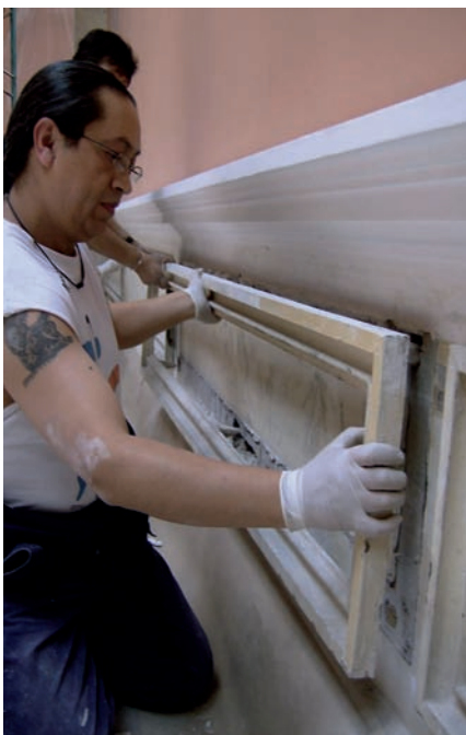
Desprendimiento de molduras deformadas.
