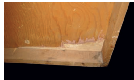
Colocación de injertos de triplay.
