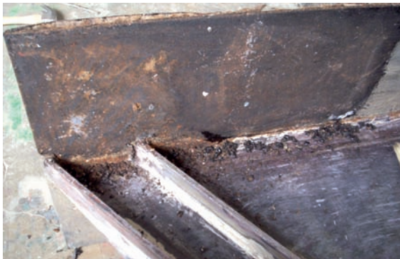
Deformación y corrosión de la base.
