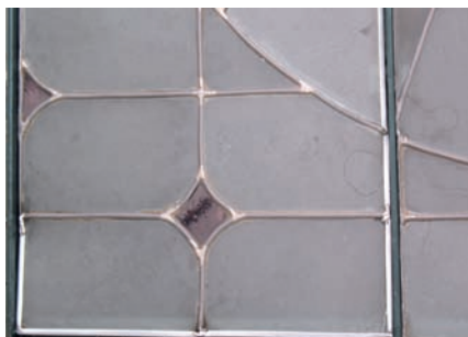
Detalle de panel restaurado con cañuela nueva, fin del proceso.
