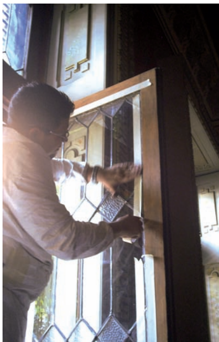
Enmascarado previo a la aplicación de la masilla.
