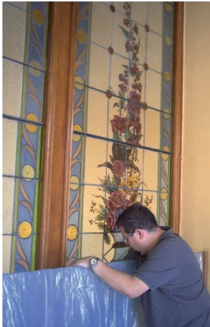
Adecuación de zonas aledañas para realizar la restauración.
