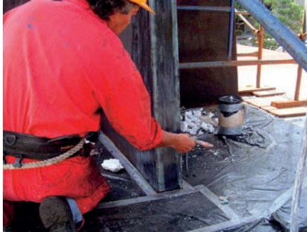
Aplicación de removedor.
