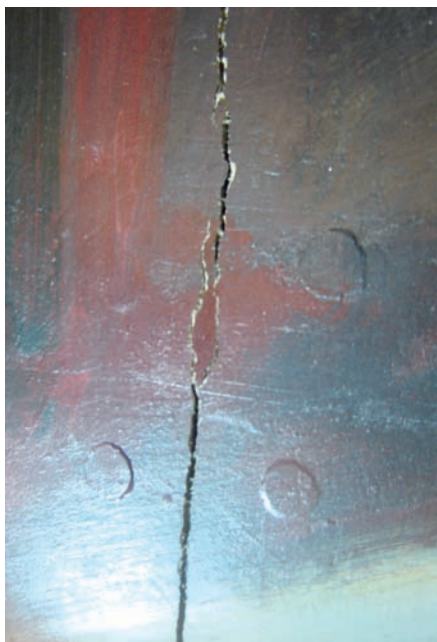
Tornillos que anclan cada panel.
