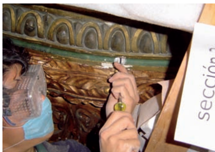
Anclaje de elementos inestables.
