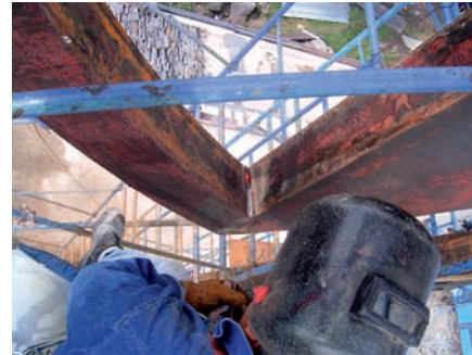
Reposición de soldaduras deterioradas.
