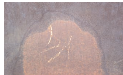
Detalle de limpieza, eliminación de grafiti.
