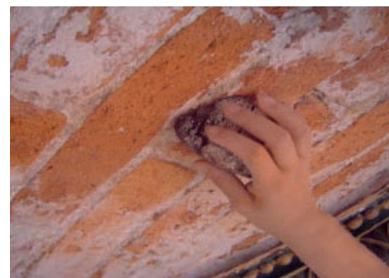
Desbaste del enladrillado.
