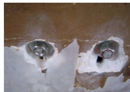
Nivel al que quedó el sistema de anclaje.
