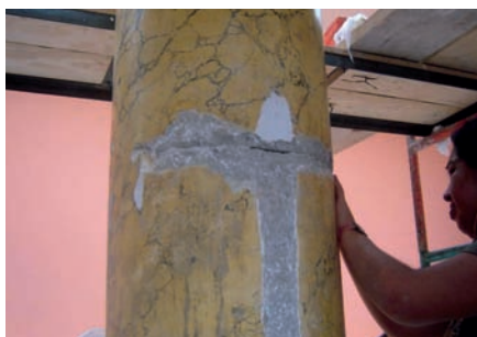
Grietas en columnas y capiteles.
