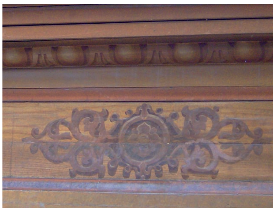
Detalle de panel de madera pintada con la técnica trompe l'oeil .
