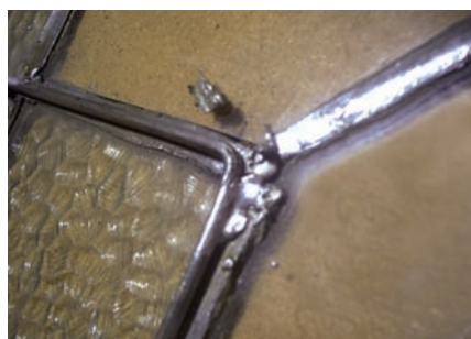
Detalle de soldadura entre cañuela y refuerzo.
