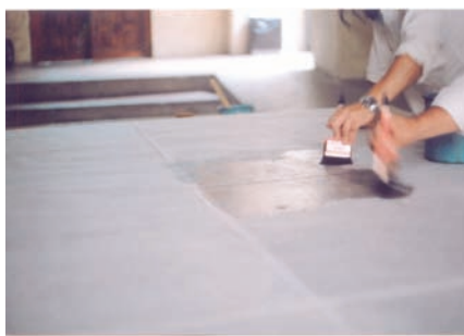
Colocación de velado.
