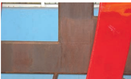
Limpieza de área con corrosión.
