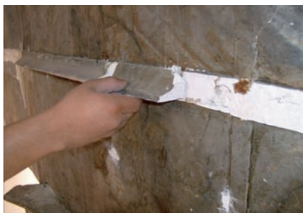
Anclaje de las molduras desprendidas.
