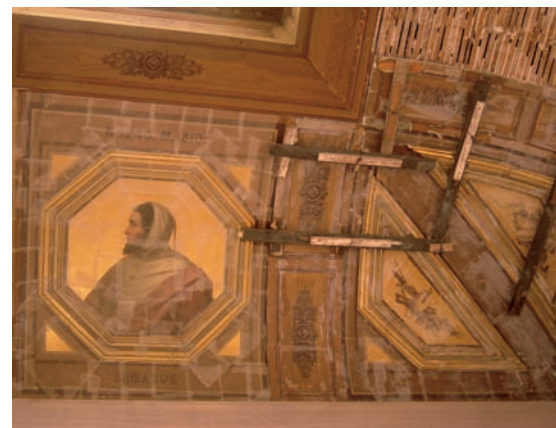
Área velada y apuntalada.
