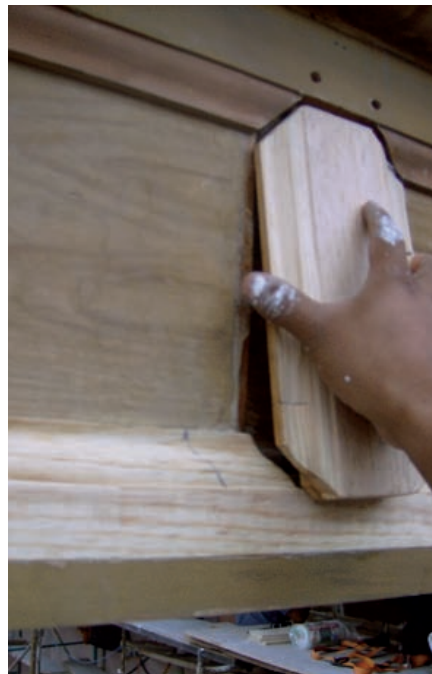
Reposición de faltantes.
