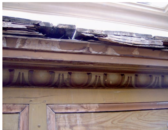
Deterioro de marco perimetral a los tragaluces.
