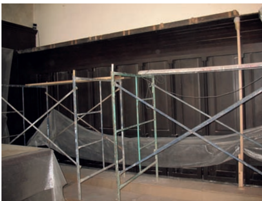
Toma general de la sillería.
