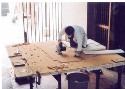
Desbastado del soporte rígido de la tercera sección.
