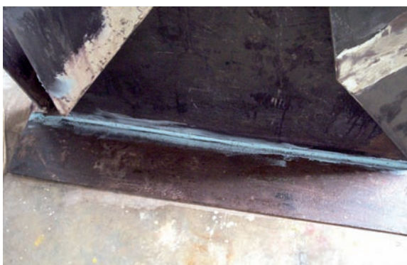
Colocación de pasta para nivelar.
