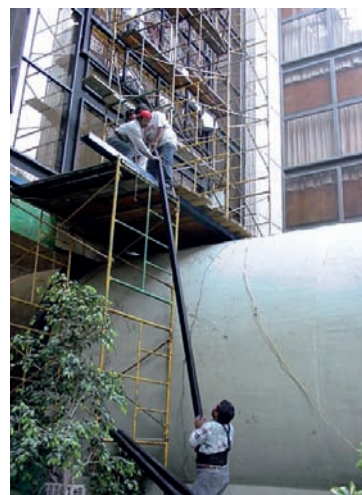
Colocación de PTR a estructura del edificio.
