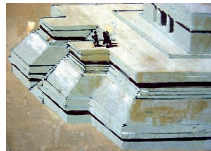
Faltantes y manchas, detalle antes de los procesos.
