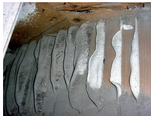
Sistema de anclaje del yeso al plafón.
