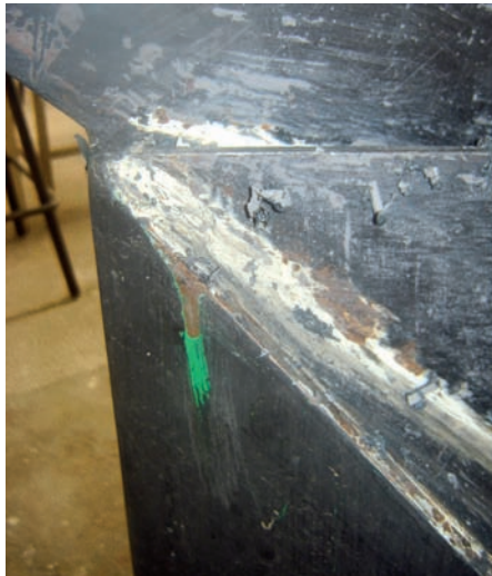
Realización de calas exploratorias.
