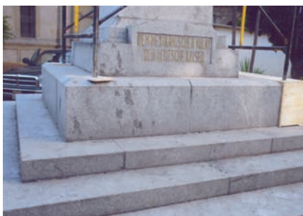
Suciedad y manchas en la base.
