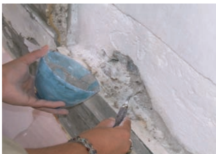
Resane de faltantes argamasa.
