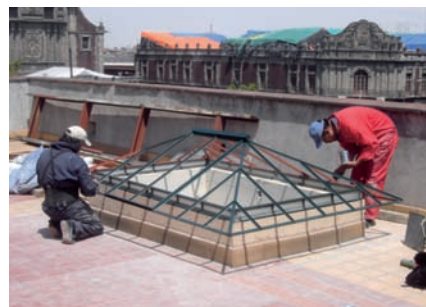
Aplicación de capa de protección de la estructura de acero.
