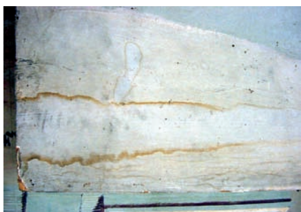
Halo generado por escurrimiento.
