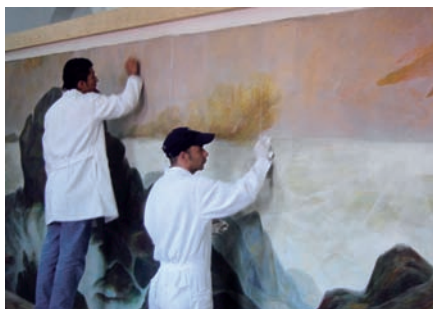
Limpeza general previa al velado de protección.
