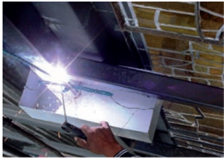
Soldando PTR para aplicar la soldadura.
