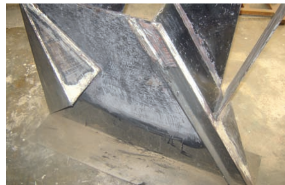
Eliminación de los productos de corrosión.
