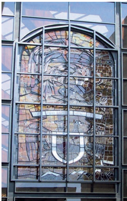
Exterior, fin de proceso.
