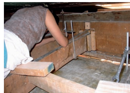
Anclado de panel, vista desde el interior del plafón.
