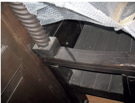
Acumulación de polvo en la superficie de la sillería, detalles.
