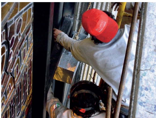
Colocación de PTR para aplicar la soldadura.
