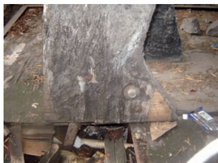
Deterioro en la parte inferior de las figuras.
