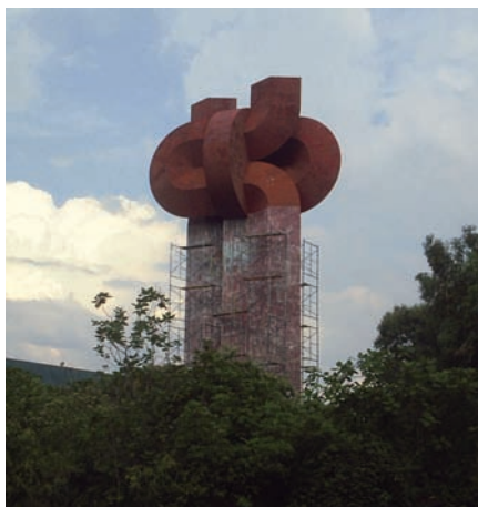
Eliminación de capa pictórica deteriorada.
