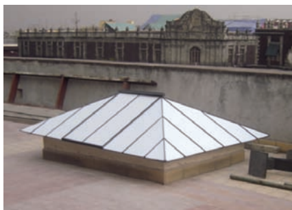
Domo con cubierta de policarbonato, fin de proceso.
