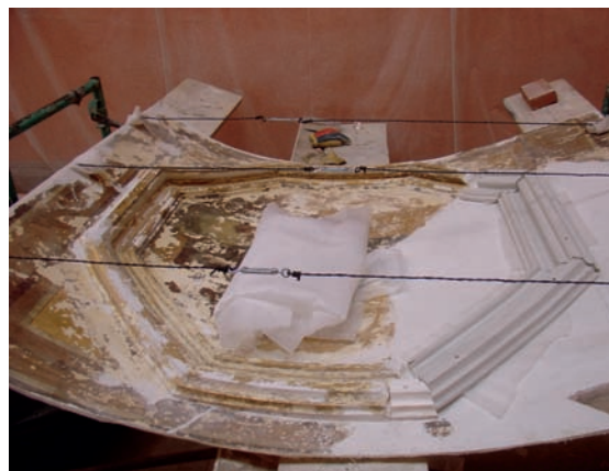
Detalle de faltantes en los paneles del muro oriente.
