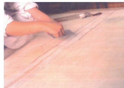
Tratamiento local sobre rotura.
