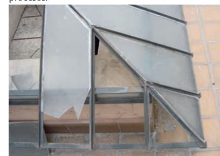
Vidrios rotos de domo de protección.
