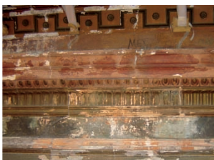
Deterioro causado por humedad.
