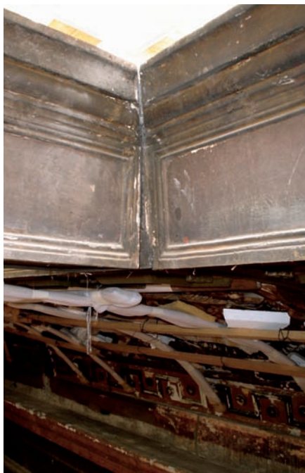
Desfase de la estructura metálica y manchas de corrosión.
