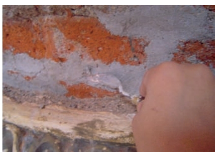
Reposición de rejunteo.
