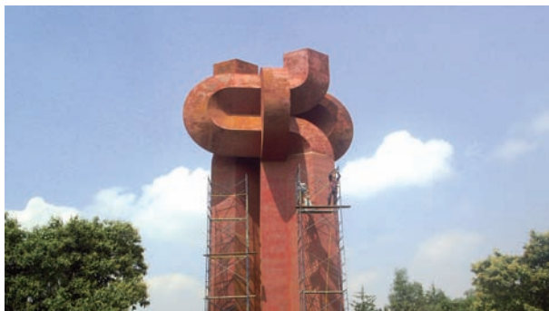
Colocación de andamios.
