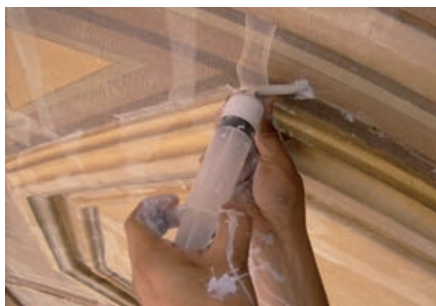
Fijado de molduras marcos octogonales.
