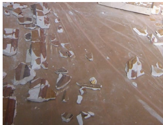
Pedacería de yeso desprendido que se conservó en cajas.
