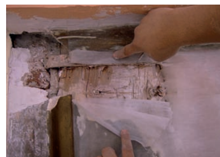
Pérdida de aplanados.
