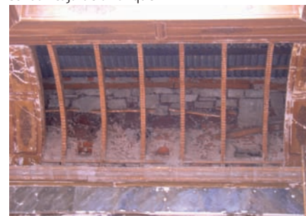
Cerchas antes de proceso.
