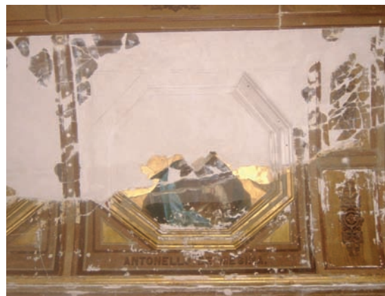
Colocación de marcos de yeso a paneles.
