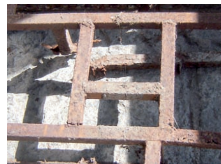
Corrosión en la estructura metálica.
