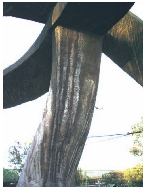
Manchas de escurrimientos.
