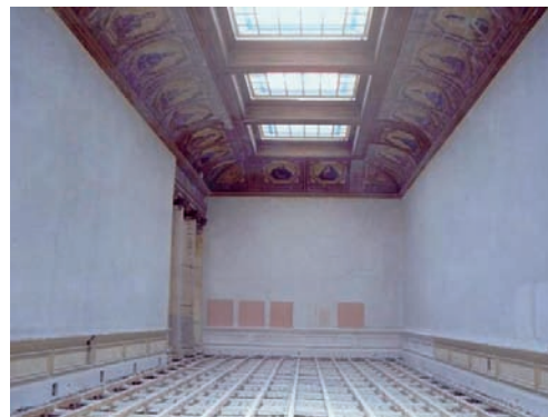
Galería Clavé durante intervención estructural.
