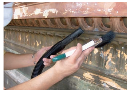
Limpieza superficial con brocha y aspiradora.
