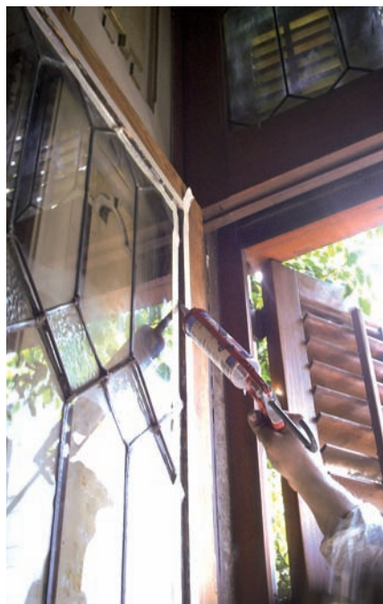
Aplicación de masilla acrílica.
