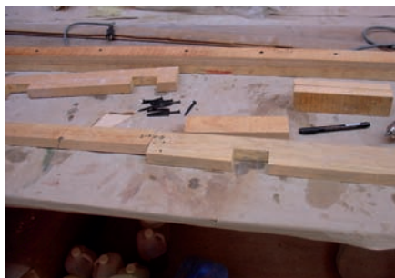
Construcción de separadores.
