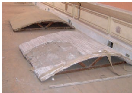
Paneles desmontados sobre camas de arranque.
