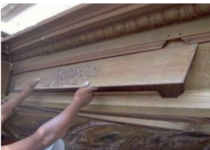
Recolocación y ajuste del panel retirado.
