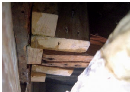
Colocando panel a su lugar con cerchas preparadas.
