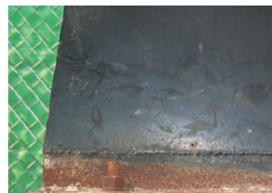
Detalle de la corrosión de la base antes de los procesos.
