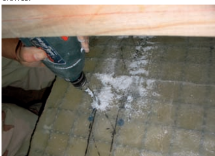
Perforación de panel.
