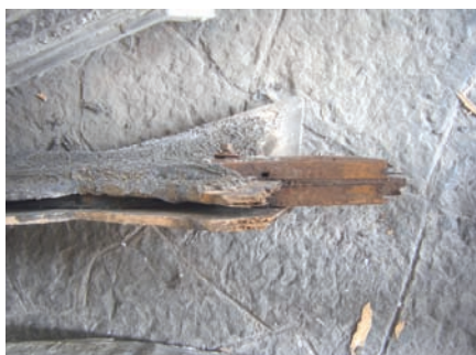
Deterioro en los anclajes de las figuras.
