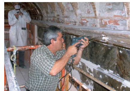
Perforación en cornisa para recuperar el nivel original.
