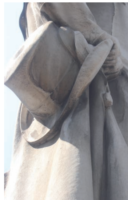
Manchas de escurrimiento y cristalización de sales.
