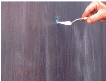
Resanado de perforaciones.
