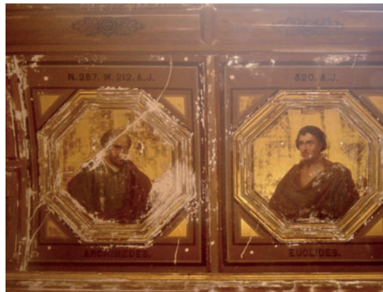
Sección limpia con resanes, durante proceso.
