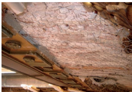
Colocación de malla de gallinero.
