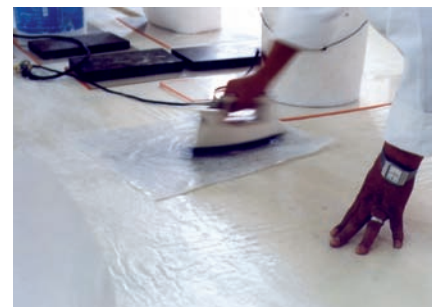
Colocación del entelado de soporte.
