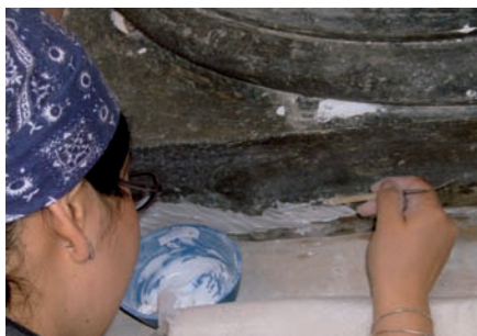
Resane de faltantes y grietas.
