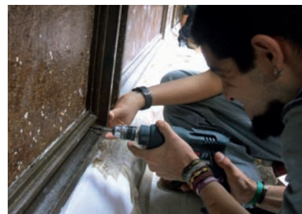
Anclaje de molduras.
