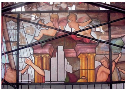
Pérdida de cristales en varias zonas.
