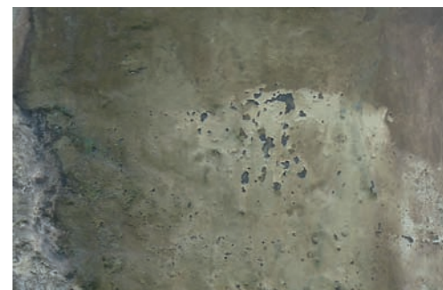
Desprendimiento del acabado blanco.
