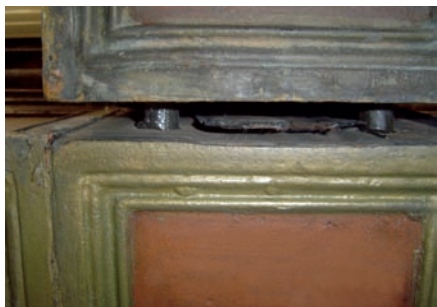
Colocación de los casquillos.
