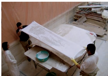
Colocación de tela embebido en yeso.
