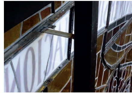
Solera de sujeción del bastidor al vitral.
