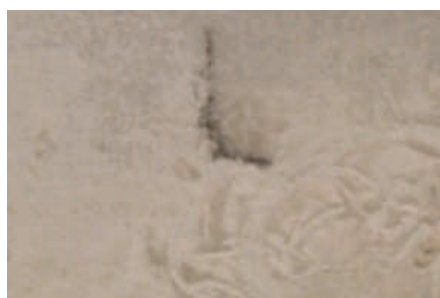
Rotura antes del proceso.
