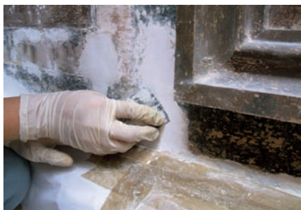
Resane de faltantes.
