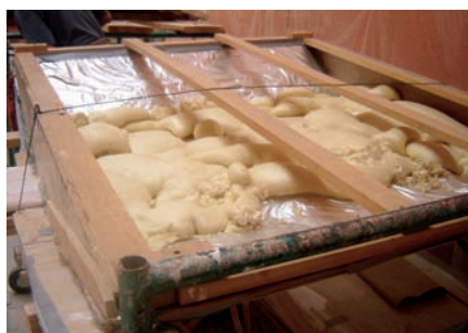
Aplicación de espuma de poliuretano y construcción de contramolde, antes de los procesos.
