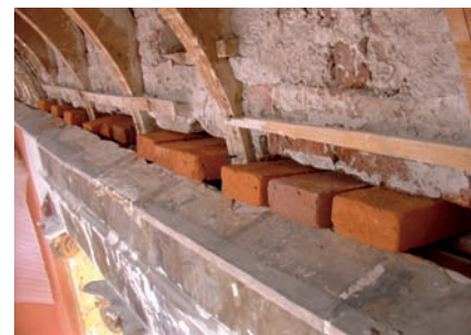
Detalle de la cornisa e hilada de ladrillos para consolidar caja de arranque.
