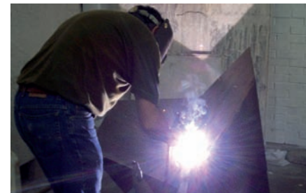
Soldadura de la placa metálica.
