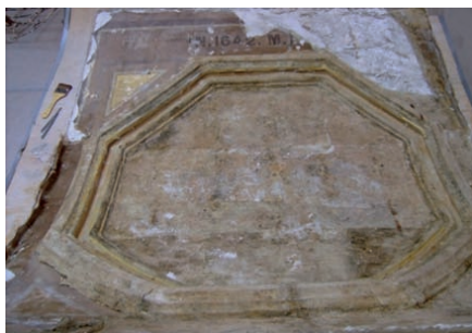
Obra durante develado de panel.
