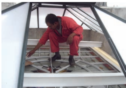
Colocación de la instalación eléctrica tragaluz de la escalera.
