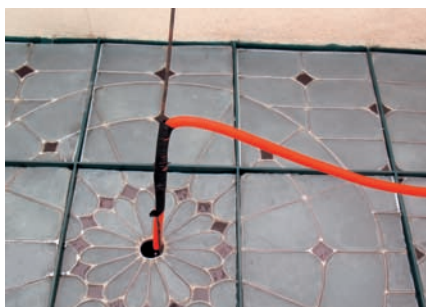
Detalle de tragaluz restaurado con instalación eléctrica.
