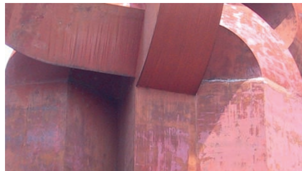
Detalle de la parte superior antes del proceso.
