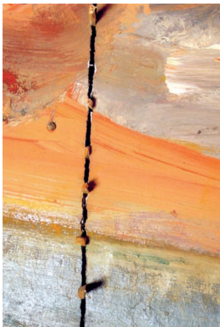
Colocación de cuñas de madera en la unión de los paneles.
