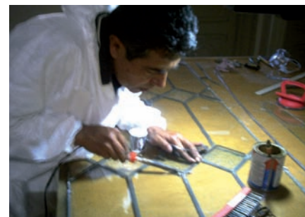
Colocación de cañuela para sujetar la reposición.
