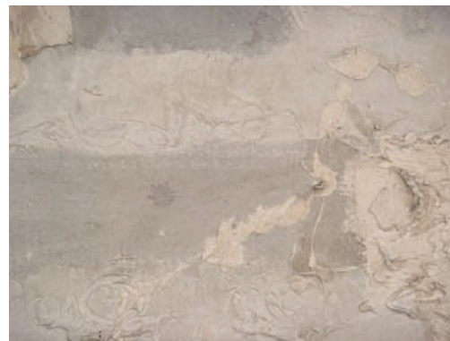
Detalle de las manchas y suciedad.
