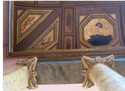
Columnas, capiteles y arquitrabe.
