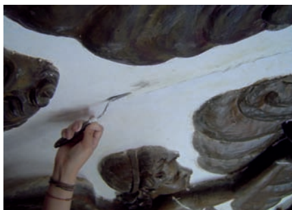
Reposición de aplanados.
