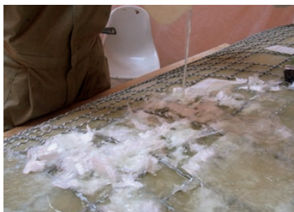
Colocación de malla metálica y resina araldith.
