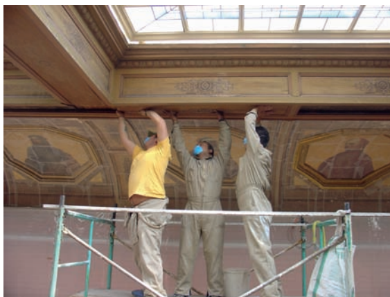
Desmontaje de paneles de madera.
