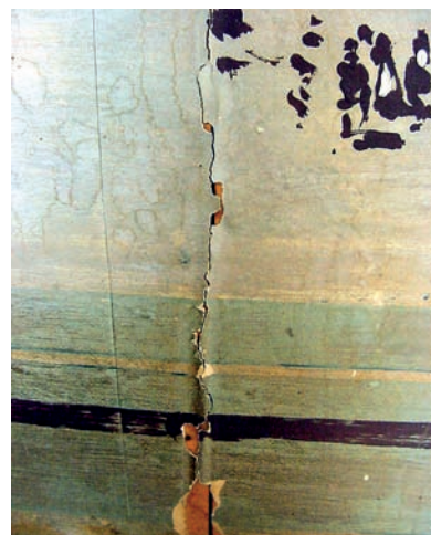
Unión en la parte central antes de los procesos.
