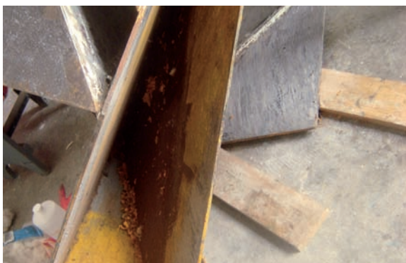
Deformación y desprendimiento de la base.
