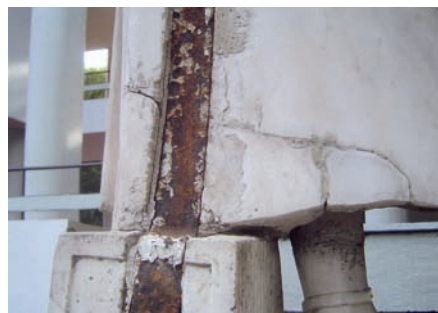
Corrosión del soporte metálico expuesto.
