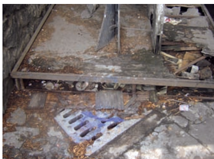
Acumulación de basura en la base.
