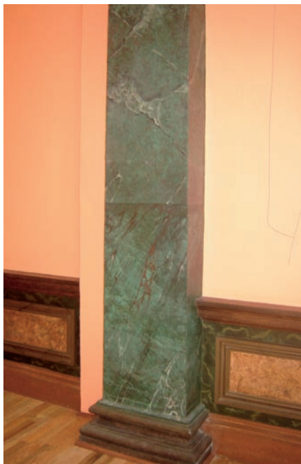
Apariencia al finalizar la intervención.
