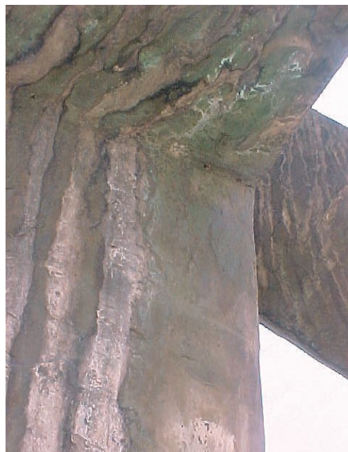
Manchas ocasionadas por los productos de corrosión.
