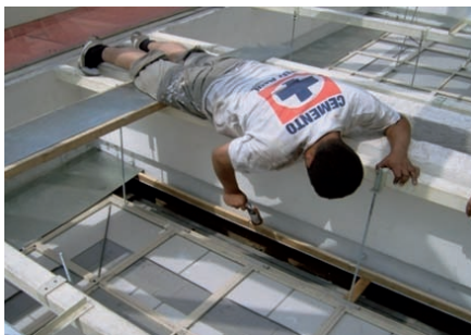
Colocación de lámina multiperforada.
