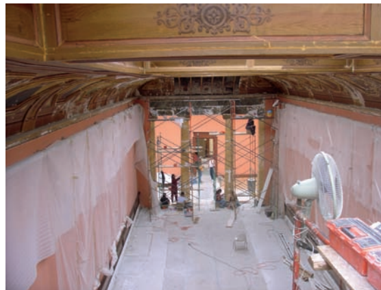
Protecciones sobre piso y muros.
