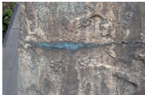
Corrosión en la soldadura.
