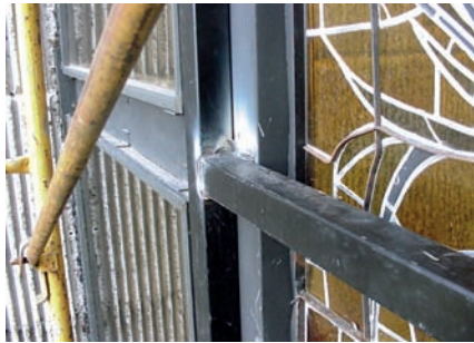
Detalle de soldadura aplicada.
