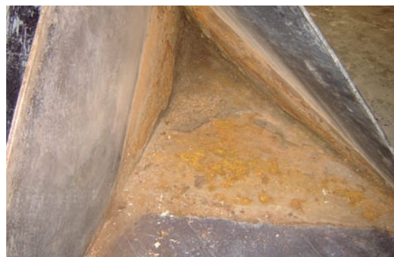
Corrosión provocada por estancamiento de agua.
