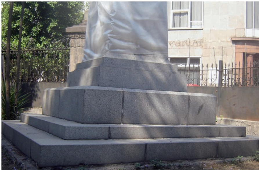
Acabado final en la base.
