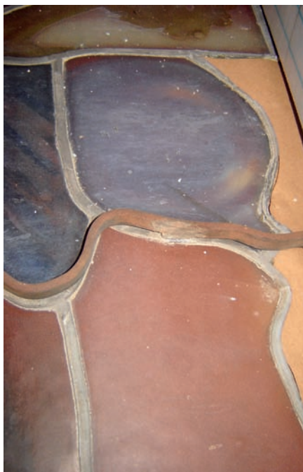
Acumulación de polvo en superficie.
