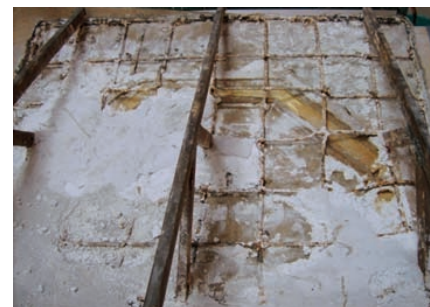
Vista de estructura metálica.
