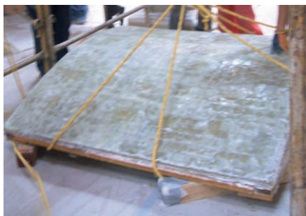
Panel antes de subir a plataforma de andamio.
