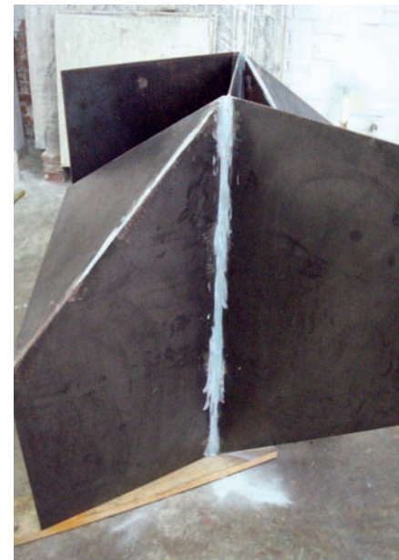
Colocación de pasta para nivelar.
