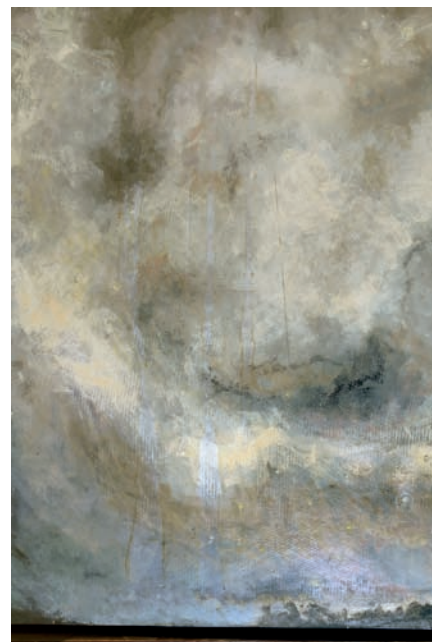
Suciedad depositada en superficie.
