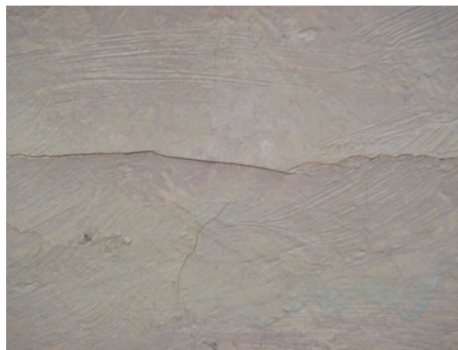
Zona de craqueladuras.
