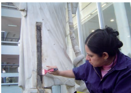
Pasivación del soporte metálico.
