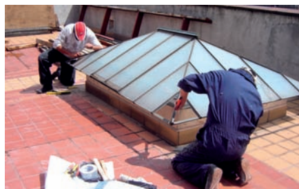
Eliminación de vidrio y mastique de domo.
