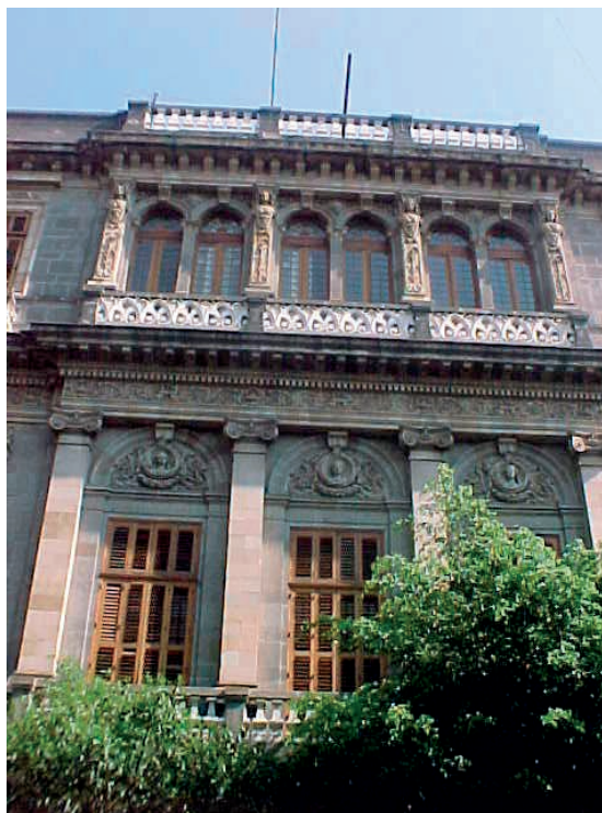
Fachada principal del inmueble.
