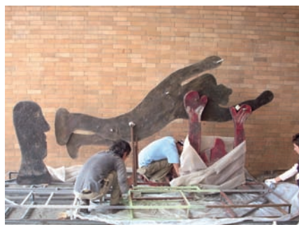
Armado de la estructura metálica.
