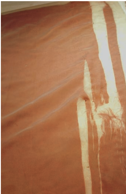
Colocación del velado de protección.
