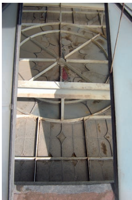
Tragaluz de la escalera, vista exterior antes de los procesos.
