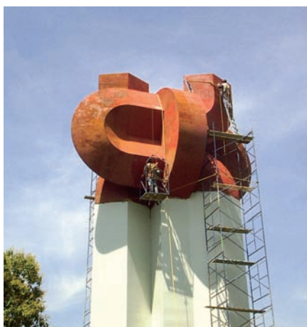
Aplicación de primer .
