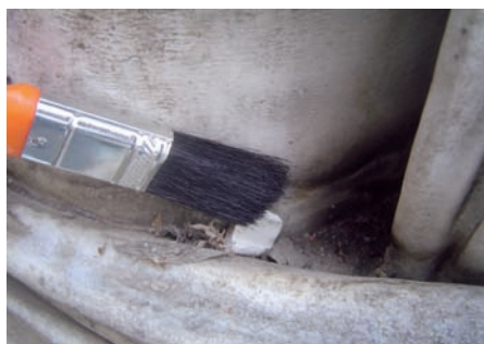
Limpieza mecánica con brocha.
