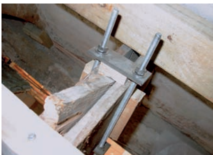
Grapa de sujeción para el panel, sistema de anclaje sobre la cercha.
