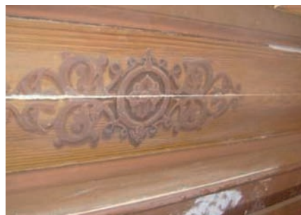
Resane de grietas.
