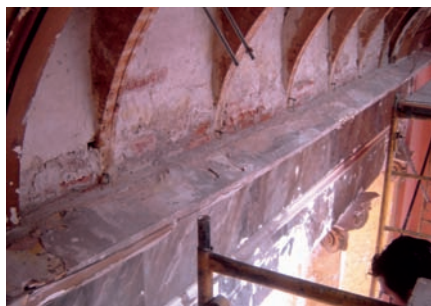
Consolidación de muro, caja de arranque de las cerchas y cornisa.
