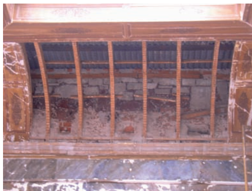
Cerchas después de eliminar listones de madera desde abajo, acercamiento.
