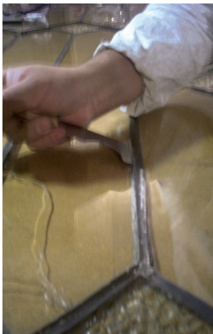
Retiro de cañuela perimetral de cristal roto.
