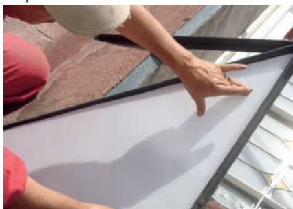
Colocación de policarbonato durante el proceso.
