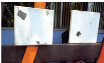
Faltantes de capa pictórica.
