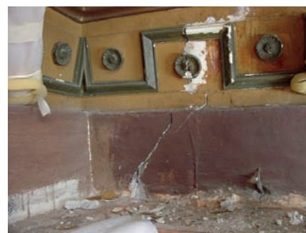
Suciedad acumulada y grietas.
