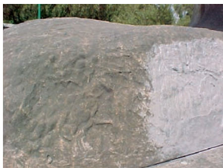
Eliminación de la capa blanca.
