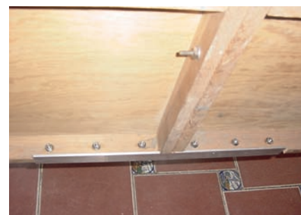
Colocación de ángulos de aluminio.
