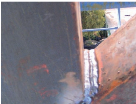
Soldadura nueva eliminando perforaciones y faltantes.
