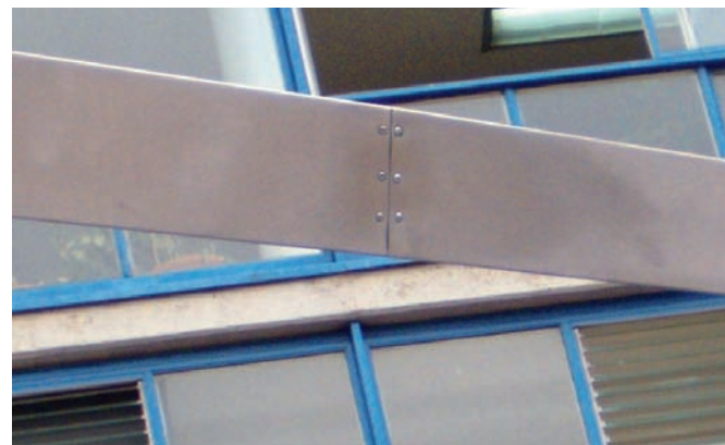
Remoción del enmascarillado.
