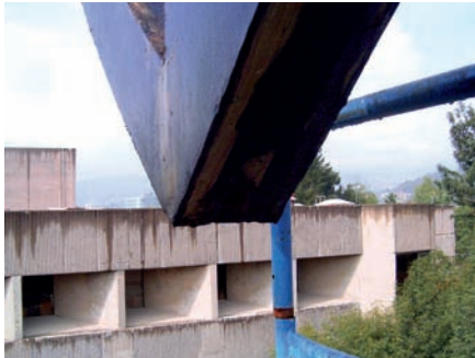
Fisuras y escurrimiento en la parte superior de la escultura.
