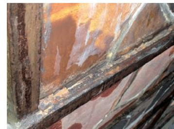
9: Detalle de la corrosión en la estructura de sujeción.
