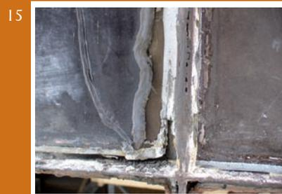
Las barras de soporte que separan y sujetan a cada panel se retiraron para eliminar la suciedad y corrosión presente; una vez finalizada la limpieza se pintaron con esmalte negro y se reintegraron a sus marcos originales.
