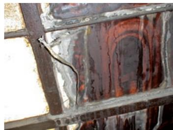
8: Detalle de desprendimiento de una de las barras de sujeción.
