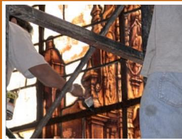
En primer lugar, se realizó el desmontaje de los treinta paneles que conforman el vitral por la cara posterior del edificio, los cuales se embalaron cuidadosamente para transportarlos a un taller y efectuar los procesos de restauración pertinentes. Se empezó por una limpieza fisicoquímica con agua destilada y solución jabonosa para eliminar la suciedad acumulada, auxiliándose de telas de lana o algodón, y, posteriormente se continuó con una limpieza química para retirar los velos salinos.
